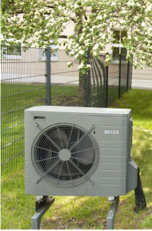
Abb. 2 | Außeninheit für Luftwärmepumpe, Bohrung für Erdsonden-Wärmepumpe und installierte Wärmepumpe im Heizungsraum
