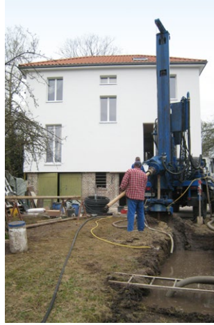
Abb. 2 | Außeninheit für Luftwärmepumpe, Bohrung für Erdsonden-Wärmepumpe und installierte Wärmepumpe im Heizungsraum
