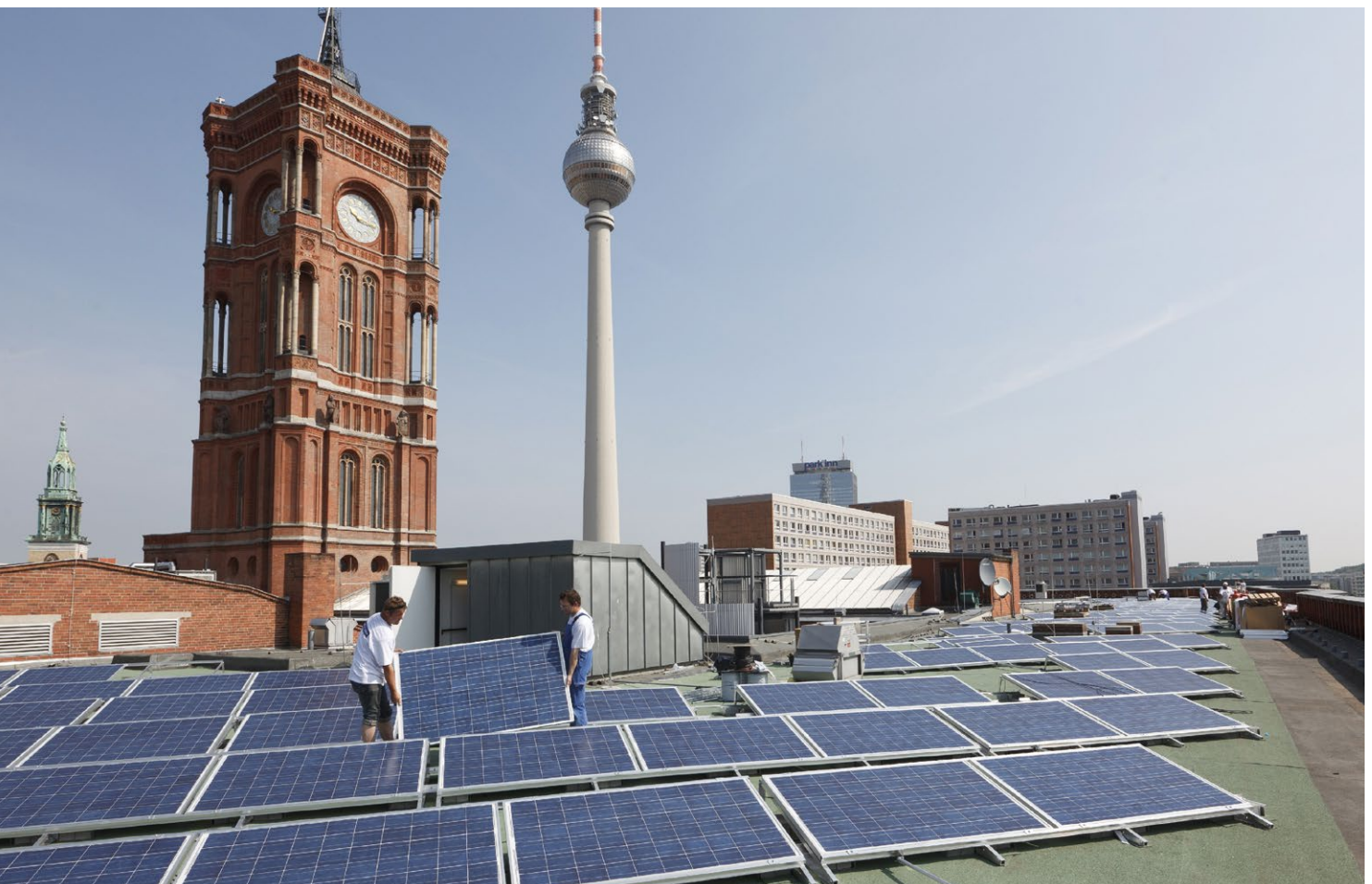
Abb. 21 | PV-Anlage auf dem Dach des denkmalgeschützten Roten Rathauses /Berliner Energieagentur GmbH/7/
