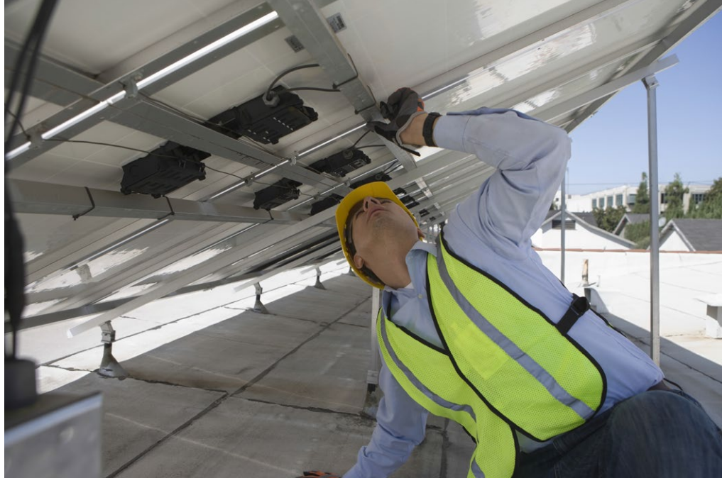
Abb. 22 | Überprüfung der PV-Anlage von einer Fachfrau / einem Fachmann / 8/
