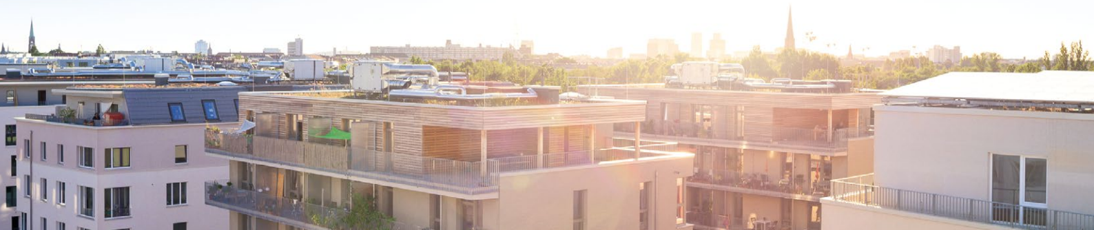
Abb. 13 | Neubauquartier der Möckernkiez eG, erneuerbares Energiekonzept mit Kopplung von Strom, Wärme und Mobilität / NATURSTROM AG / 5/
