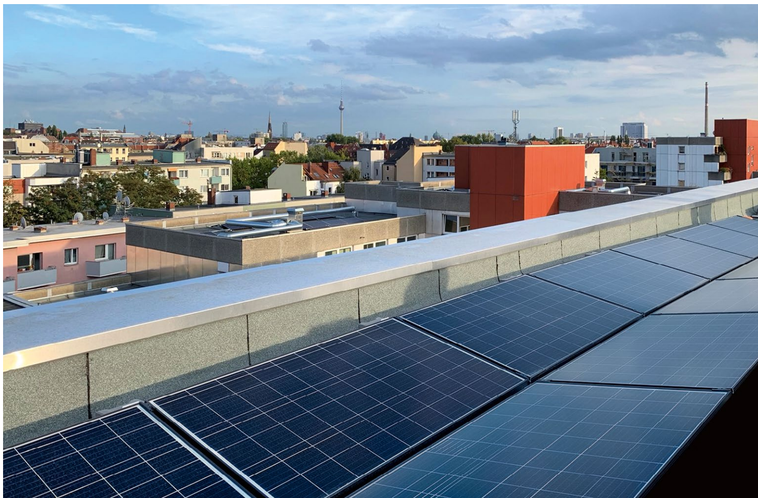
Abb. 4 | Mieterstrom-Anlage auf dem Dach eines Neubaus in der Adolfstraße, im Haus werden 85 % des Solarstroms verbraucht /SOLARIMO /2/
