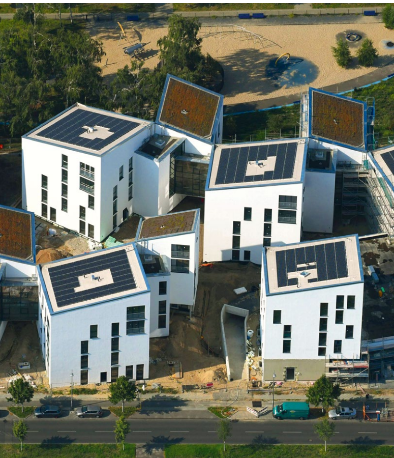
Abb. 23 | Mieterstrom-Anlage von Polarstern auf den Dächern der Neubausiedlung in Adlershof, Kenndaten auf S. 27 /9/
