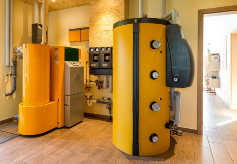
Abb. 31 | Pelletheizung und Kombispeicher sowie Holzpellets /20/
