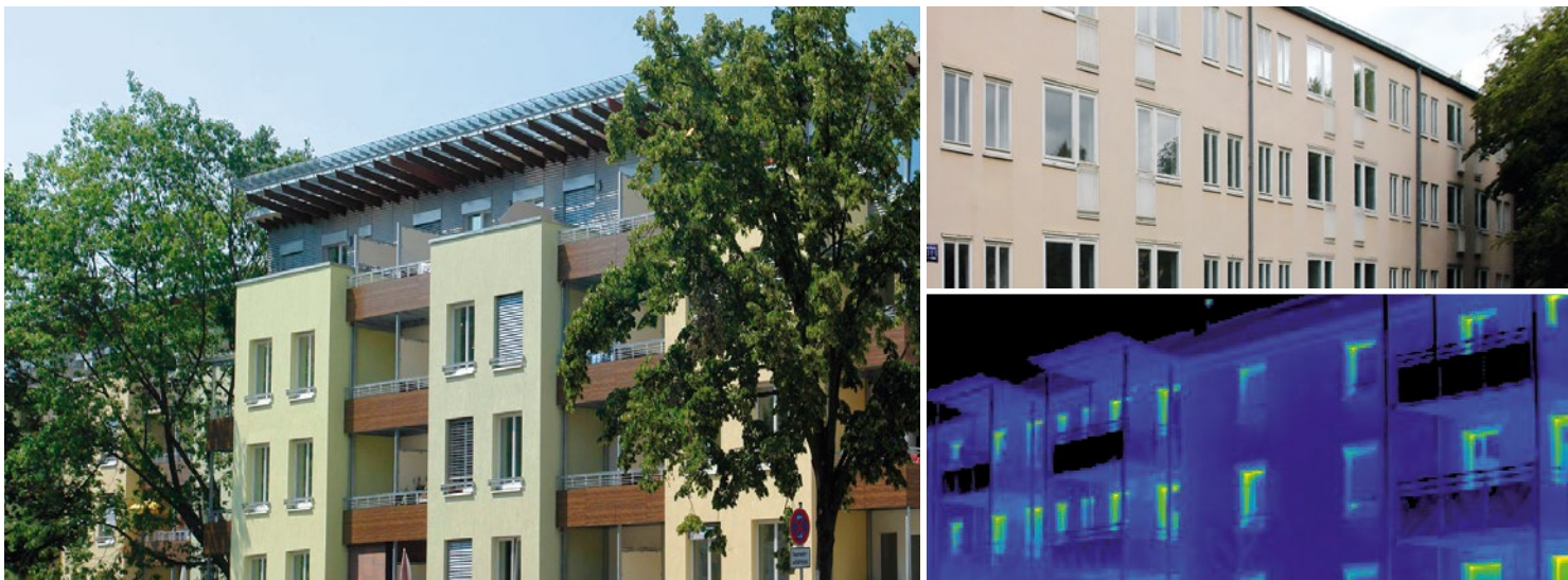
Abb. 11 | Sanierung eines 1950er Jahre-Gebäudes in Nürnberg mit Passivhaus-Komponenten und Aufstockung im Passivhaus-Standard, o. r.: Gebäude vor der Sanierung, u. r.: Thermografiebeispiel nach Sanierung / 12/
