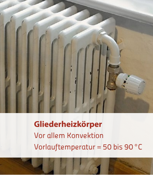
Abb. 35 | Arten von Heizkörpern und die Art der Wärmeübertragung sowie ihre typischen Vorlauftemperaturen /22/
