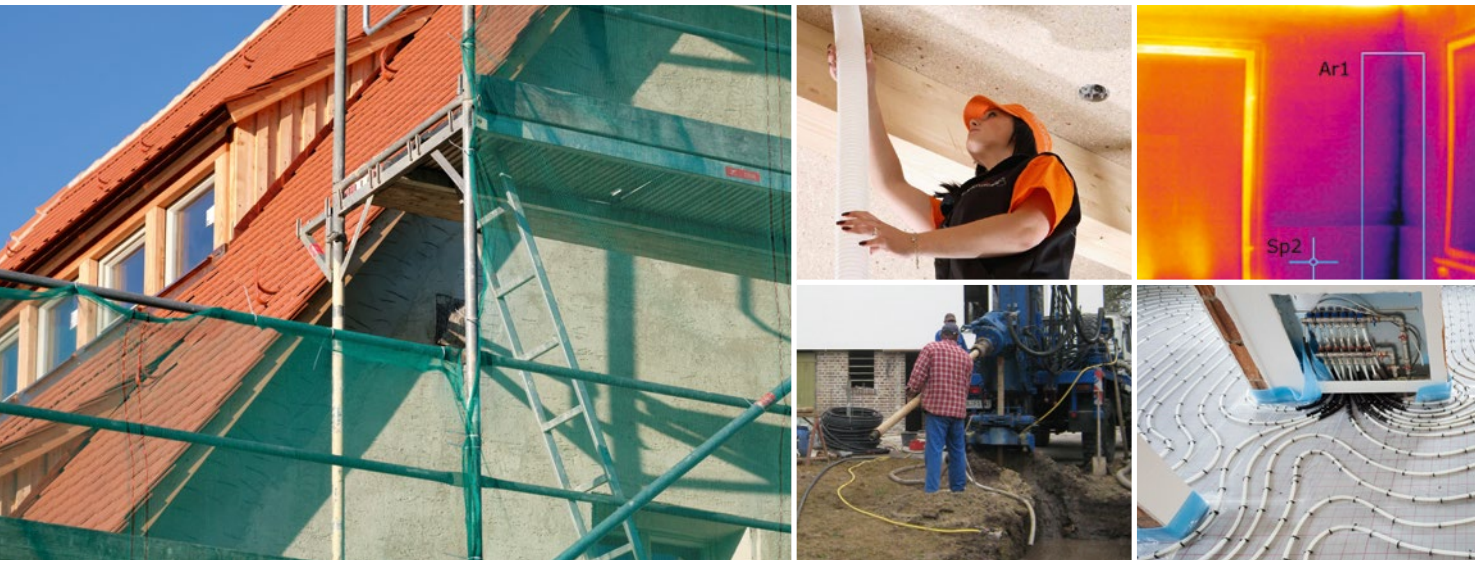
Abb. 2 | l: Eingerüstete Fassade /3/, Befüllung von Einblasdämmung mit Schlauch /4/, m. u.: Erdsondenbohrung für eine Wärmepumpe /5/, l.o. die Thermografieaufnahme zeigt eine Wärmebrücke /6/, l. u. Verlegung einer Fußbodenheizung /7/
