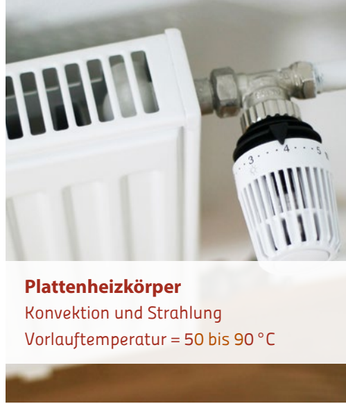
Abb. 35 | Arten von Heizkörpern und die Art der Wärmeübertragung sowie ihre typischen Vorlauftemperaturen /22/
