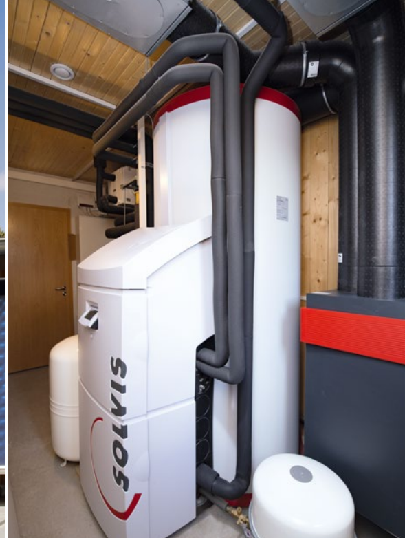
Abb. 28 | Solarthermie-Kollektoren an der Fassade befestigt und Pufferspeicher zur Trinkwassererwärmung und Heizungsunterstützung
