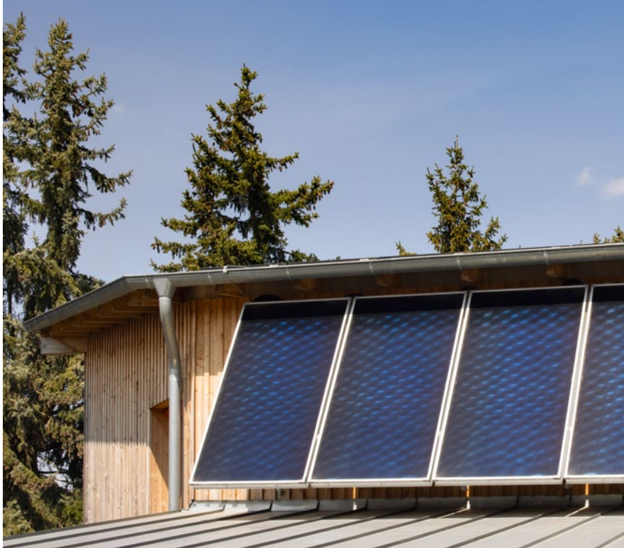
Abb. 28 | Solarthermie-Kollektoren an der Fassade befestigt und Pufferspeicher zur Trinkwassererwärmung und Heizungsunterstützung
