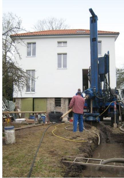
Abb. 24 | v. l. n. r.: Außeneinheit für Luftwärmepumpe, Bohrung für Erdsonden-Wärmepumpe /19/ und installierte Wärmepumpe im Heizraum
