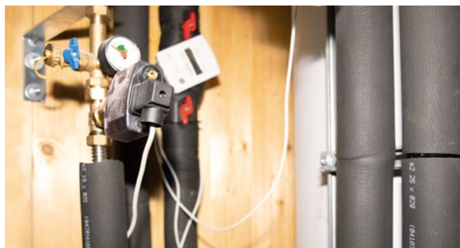
Abb. 38 | gedämmte Heizungsrohre
