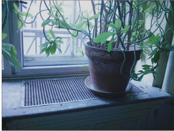
Abbildung B 8: Caterer B: verschmutzte Fensterbank
