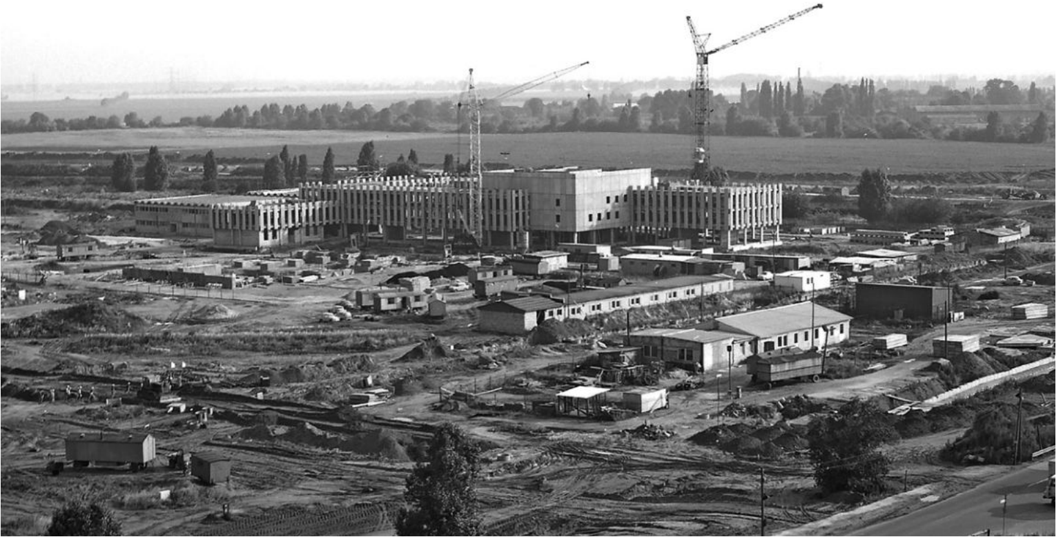
Bau des ehemaligen Handelshauses am Prerower Platz, das am 26.09.1985 eröffnet wurde
