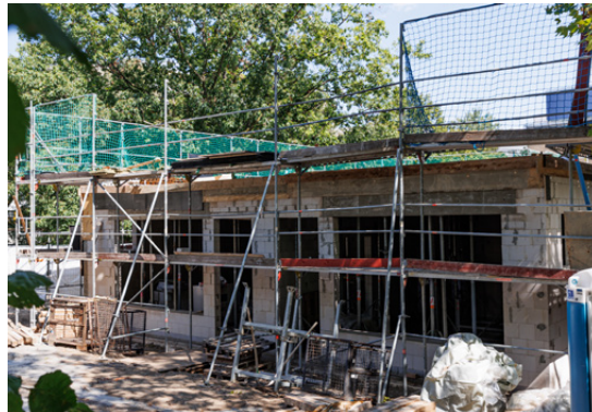
Anbau Kita am Heckerdamm
