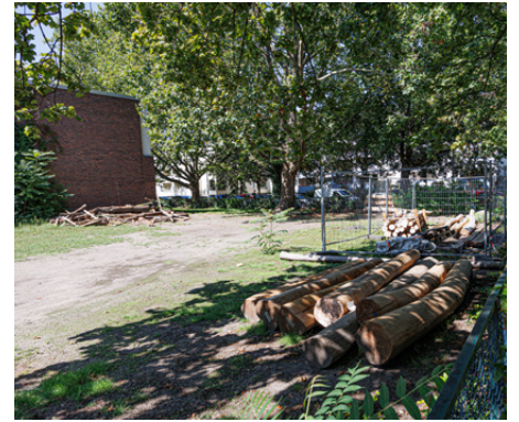
Im Bau: Spielplatz für die Moltke-Schule
