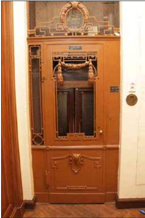
Abbildung 3.1.1: Schachttür ohne Glaseinsatz
