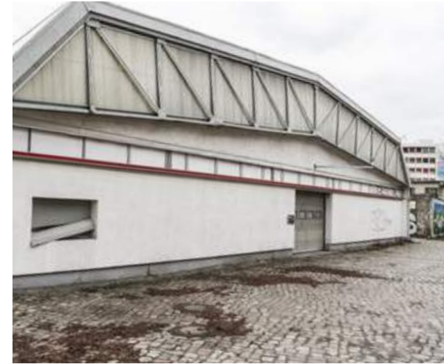
Abb. 13: Adler-Halle mit charakteristischem Stahltragwerk
