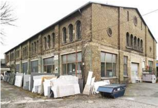
Abb. 10: ehem. alte Reithalle mit gewerblicher Nutzung
