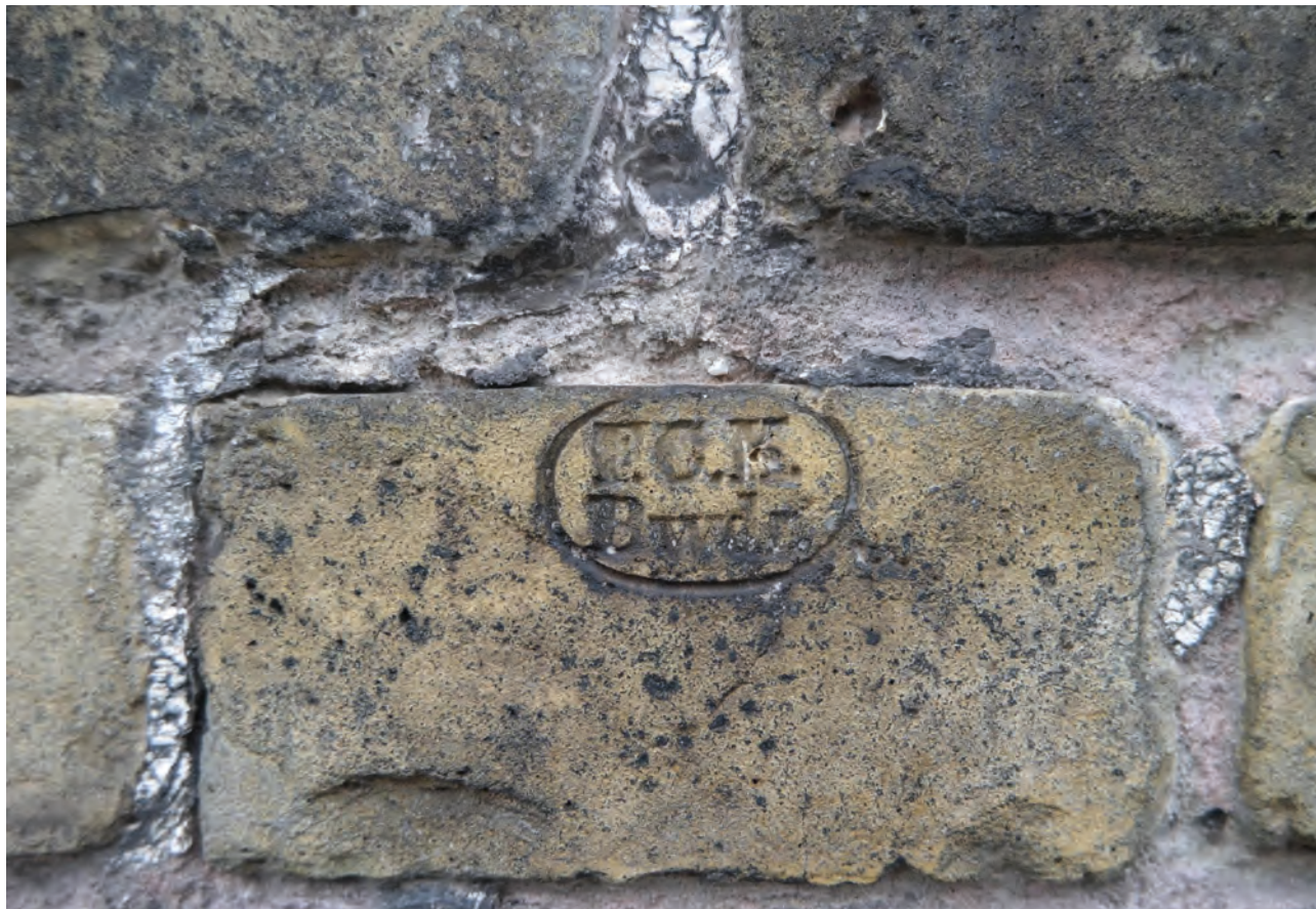
Abb. 13: Bauzeitliches kasernenzeitliches Sichtmauerwerk mit Ziegelstempel, BSQB/SDARC
