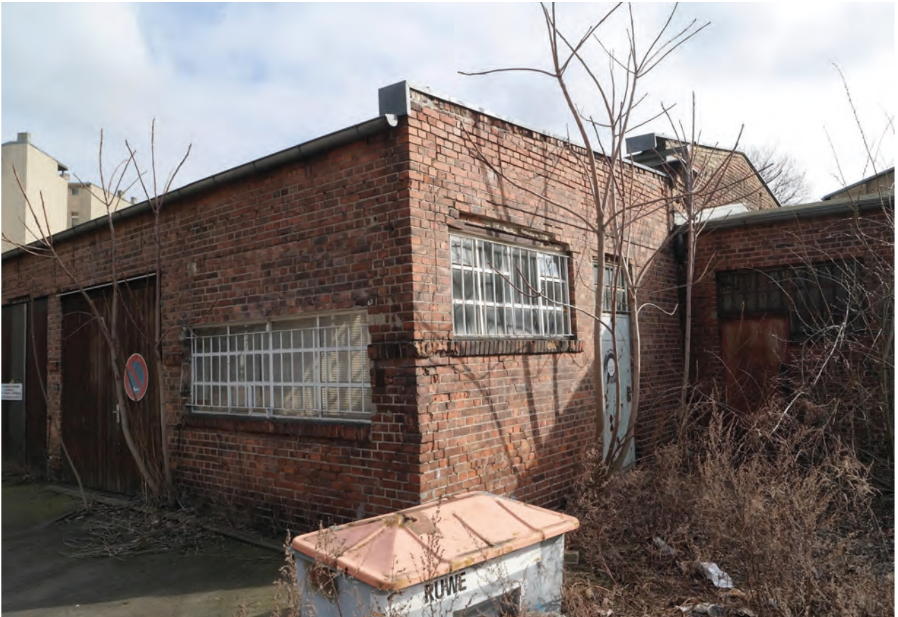
Abb. 15: In diesem Werkstattgebäude ist in Teilen substanzuell noch die alte Schmiede der Kaserne enthalten. Umbau und Veränderung statt Abriss und Neubau, BSQB/SDARC
