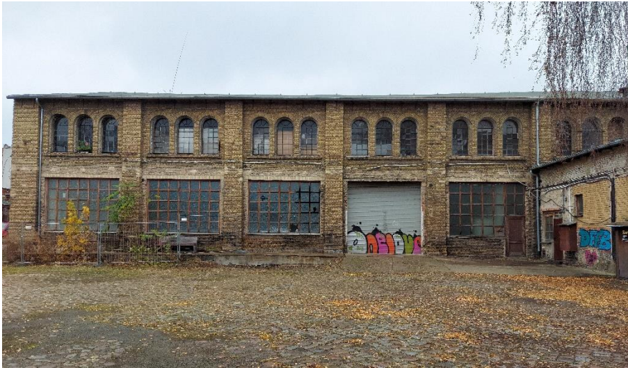
Abb. 21 Alte Reithalle, Blick auf die Südfassade
