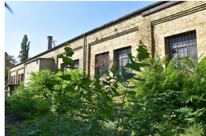
Neue Reithalle, Einsehbarkeit von Osten
