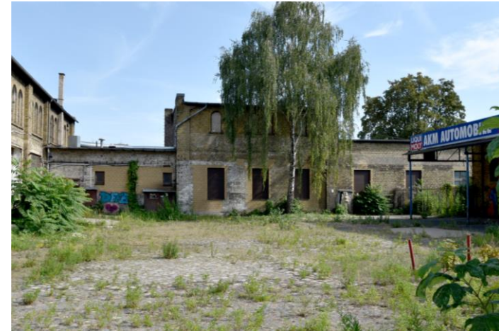
Dorfplatz mit Alter Reithalle, Kühlstall (Geb. 8) Stallflügel (Geb. 5)
