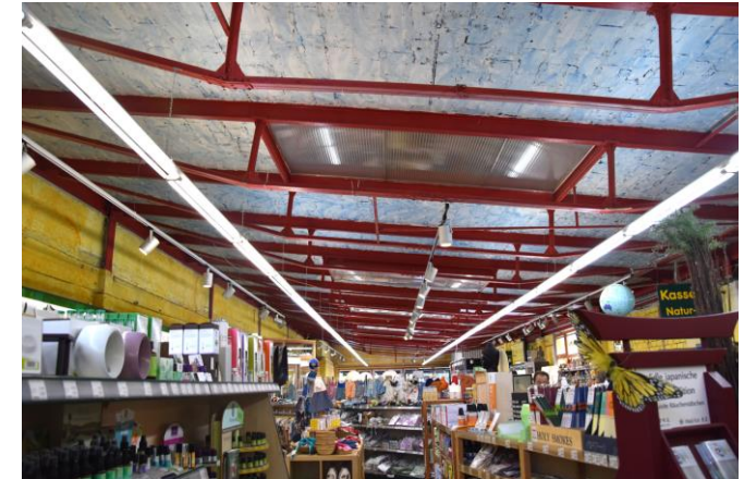
Geb. 35 Innenansicht: Decke mit Oberlichtern
