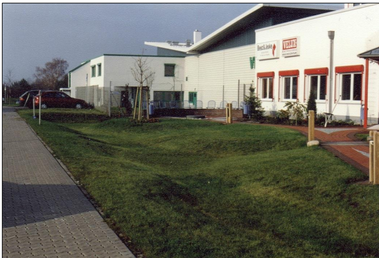
Abbildung 33: Beispiel für Mulden auf Privatgrundstücken, Gewerbegebiet Hoppegarten [Quelle: Ingenieurgesellschaft Prof. Dr. Sieker mbH 2015]
