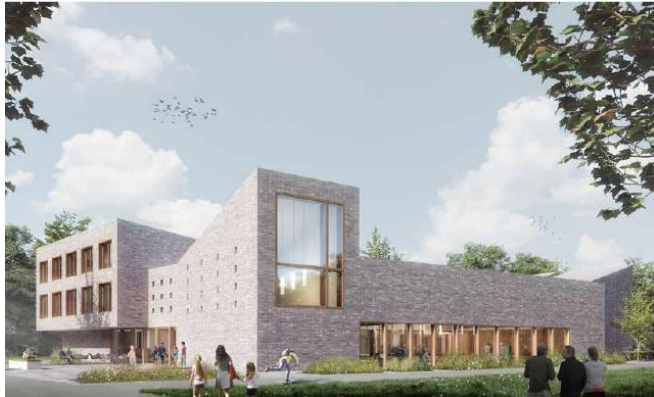
Neubau Begegnungszentrum und Kindertagesstätte für 90 Kinder
