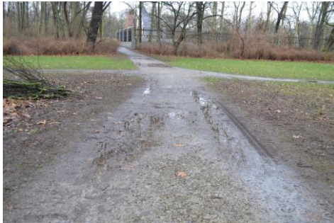
Vor der Sanierung
