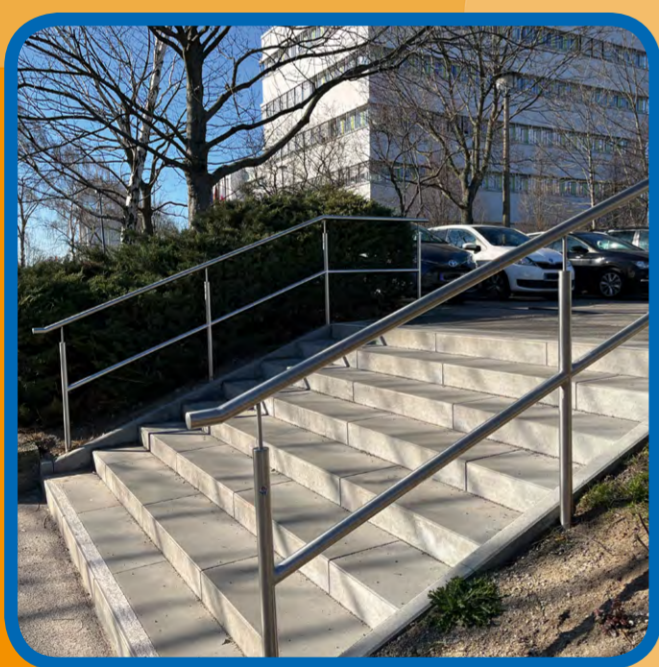
Bürgerhaushalt 2020/2021 Treppenanlage zur Martha- Arendsee-Straße erneuert
