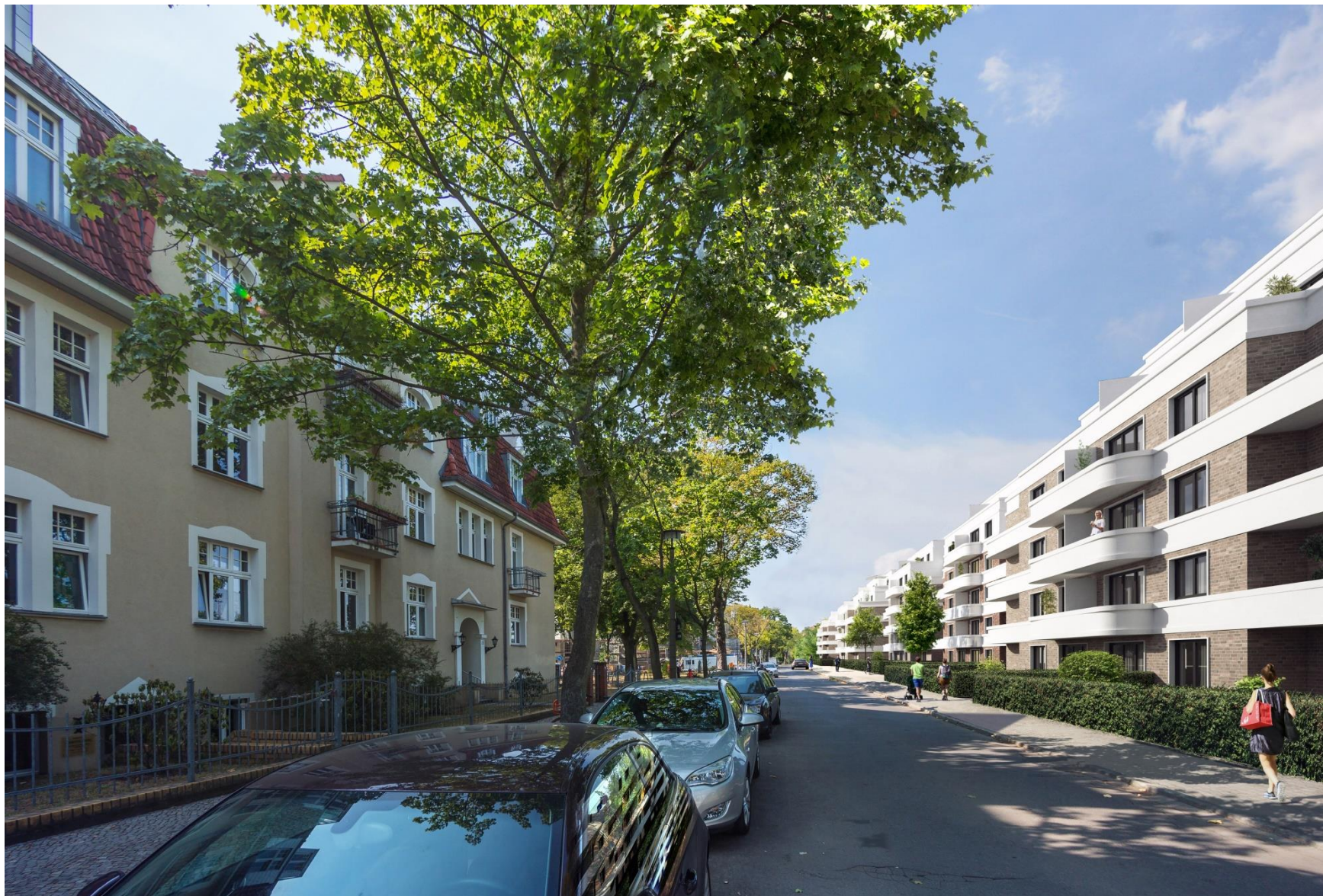
Abb. 3: Ansicht aus der Wandlitzstraße
