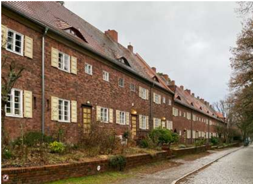
Abbildung 3 Homogene Dächer einer denkmalgeschützten Siedlung.
