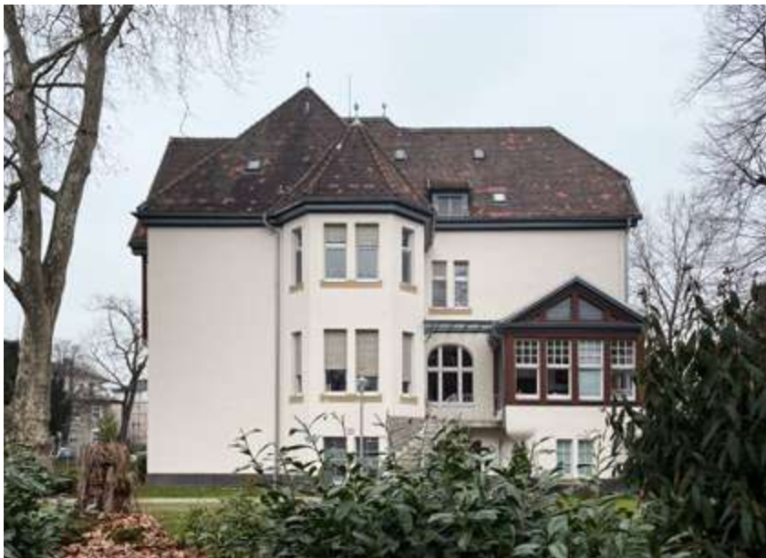
Abbildung 33 Die Dachfläche ist nur von einem privaten Garten einsehbar.
