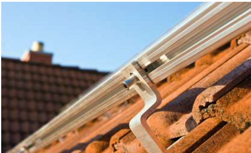
Abbildung 24 Dachhaken für die Aufdachmontage.
