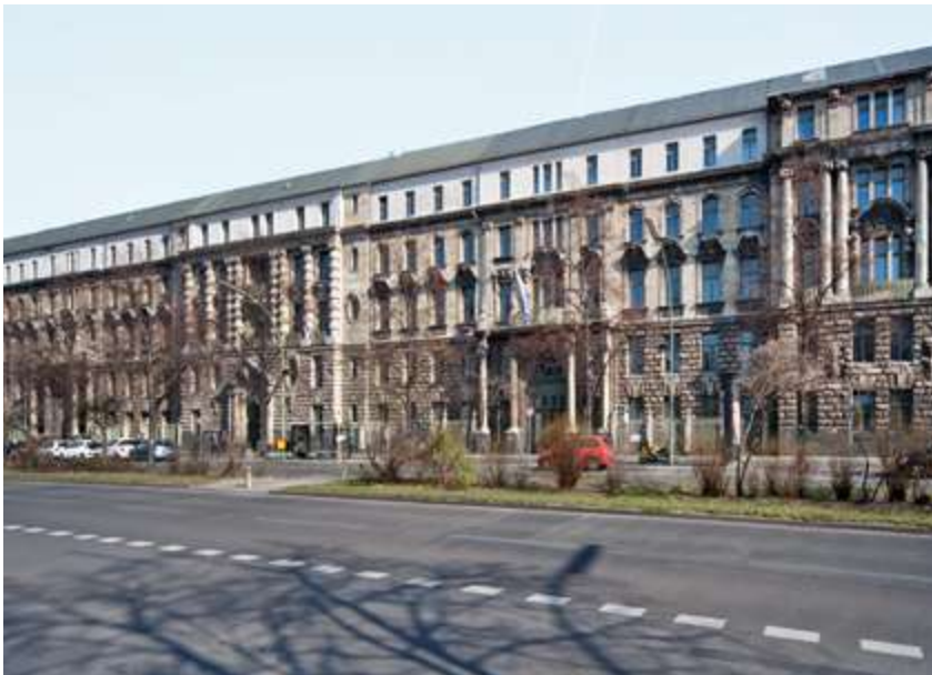
Abbildung 38 Denkmal mit überformtem, nicht bauzeittypischem Dach.
