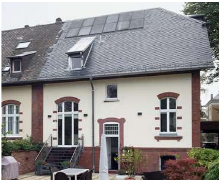
Abbildung 49 Farblich angepasste PV-Anlage auf einem Denkmal.
