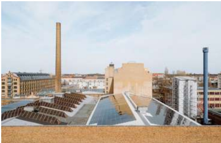
Abbildung 36 PV-Anlagen auf denkmalgeschützten ehemaligen Fabrikgebäuden.
