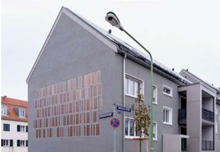
Abbildung 56 Gestaltete Photovoltaikanlage an einer Brandwand.
