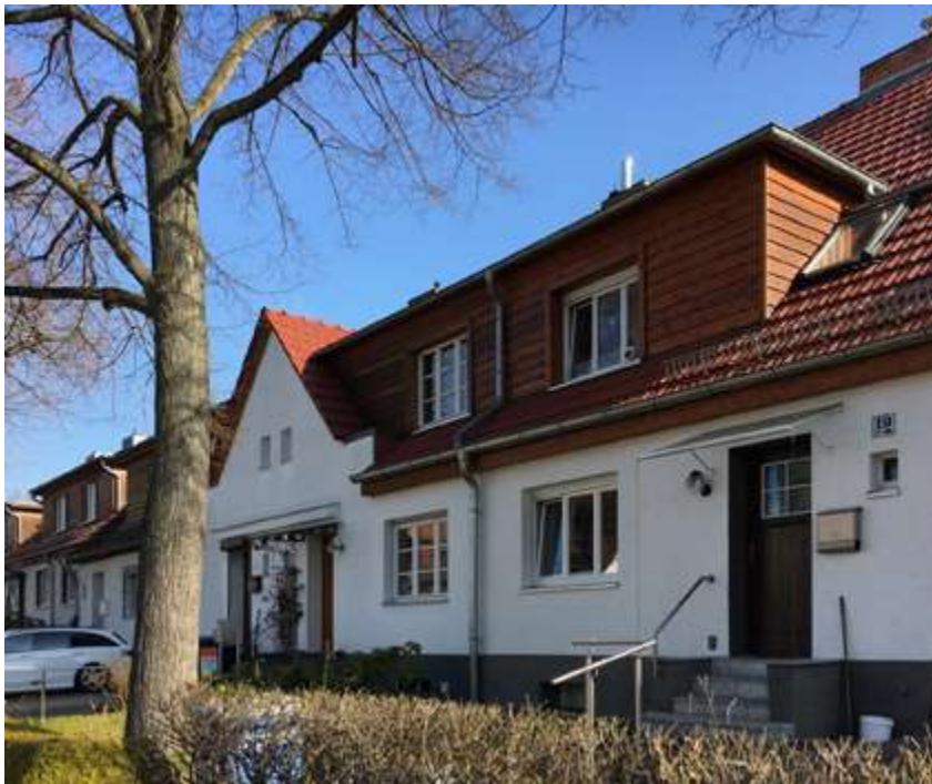
Abbildung 59 Dachflächen in einer denkmalgeschützten Gesamtanlage.
