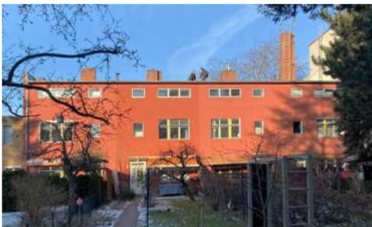
Abbildung 58 Bemusterung einer PV-Anlage in Welterbesiedlung.
