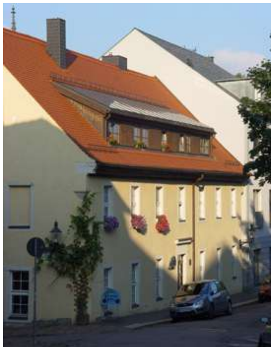
Abbildung 54 Solarkollektoren auf einer Gaupe.
