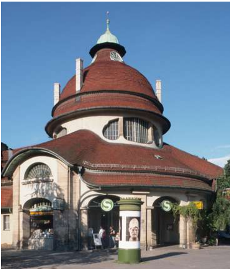
Abbildung 45 Aufwendig ausgebildetes Dach des S-Bahnhofs Mexikoplatz.
