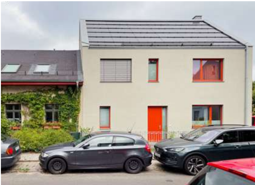
Abbildung 40 Dachintegrierte PV-Anlage auf Neubau neben einem Denkmal.
