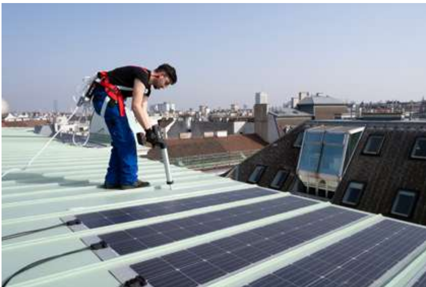
Abbildung 17 Leichte und flexible PV-Module werden auf ein Blechdach geklebt.
