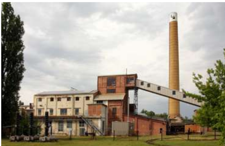
Abbildung 37 Denkmal Brikettfabrik Louise mit PV-Anlage, Dohmsdorf.
