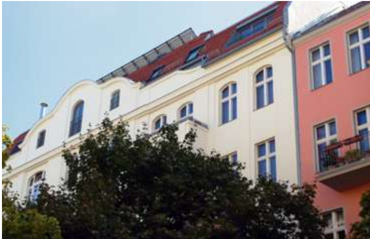
Abbildung 50 Bei einem Denkmal nicht verträglich: ungünstig über den First ragende Solaranlage.
