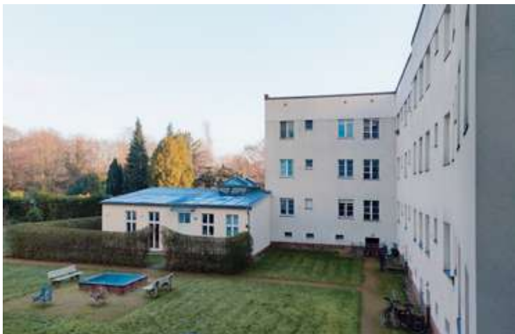
Abbildung 51 Das Dach eines denkmalge- schützten Waschhauses ist aus dem halböffentlichen Raum einsehbar, entfaltet jedoch nur eine untergeordnete städte- bauliche Wirkung. Die visuelle Beeinträchtigung konnte durch die PV-Anlage mit den sehr flachen Modulen reduziert werden, der Zeugniswert des Gebäudes bleibt gegeben.
