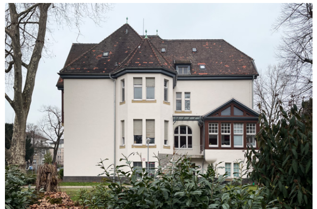
Abb. 2: Die Dachfläche ist nur von einem privaten Garten aus einsehbar
