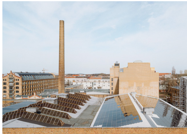
Abb. 5: PV-Anlagen auf denkmalgeschützten ehemaligen Fabrikgebäuden
