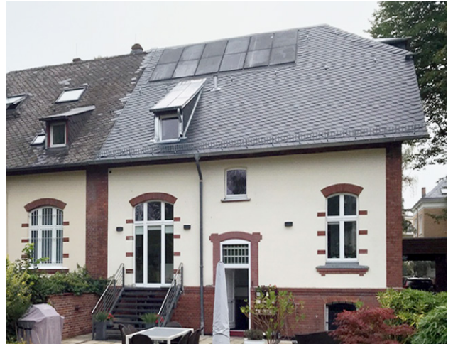
Abb. 11: Farbliche Anpassung einer PV-Anlage an die Dachdeckung durch Auswahl monochromer, matter Module
