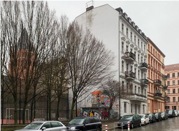
Abb. 7: Brandwand in einem Denkmalbereich
