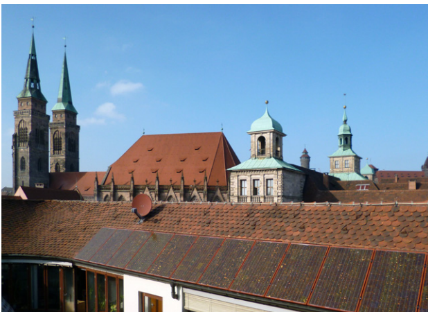
Abb. 13: An Dachdeckung farblich angepasste Module
