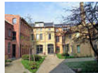
Gartenstraße, ehem. Wäscherei
