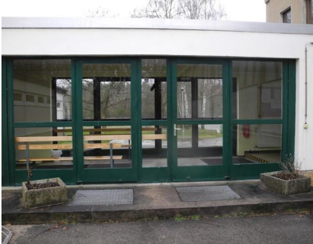
Verbinder zwischen Sporthalle und Gymnastikhalle
