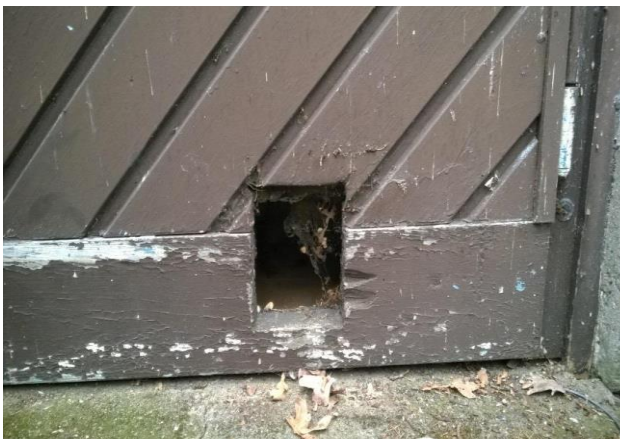
Außentür (Ost-Seite) zu einem beheizten Raum
