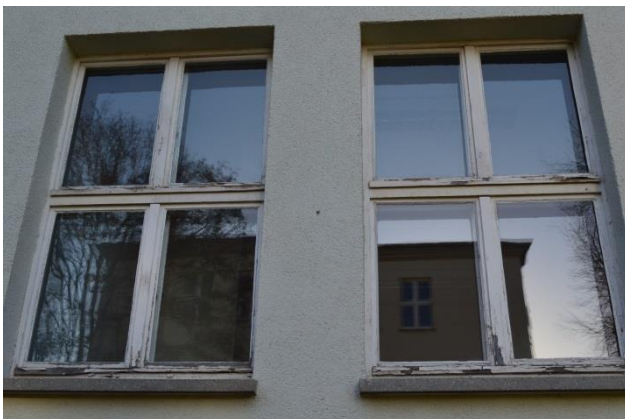
Unsanierete Kastenfenster im EG der Süd-Ost-Fassade
