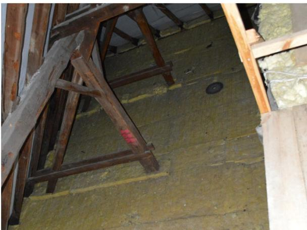
Dämmung der Decke zum unausgebauten Dachraum
