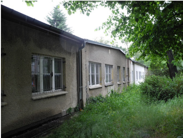
Nord-West Ansicht (Straßenseite)
