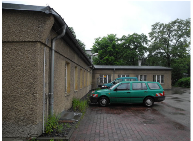
Süd-Ost Ansicht (Herrenumkleideräume)
