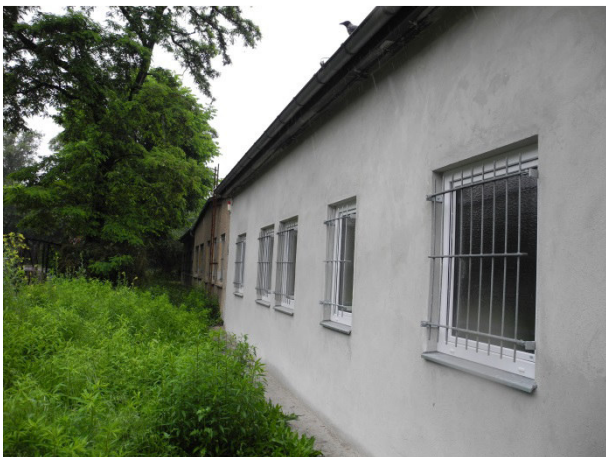
Sanierte Fassade (Sanitärraum Damen)
