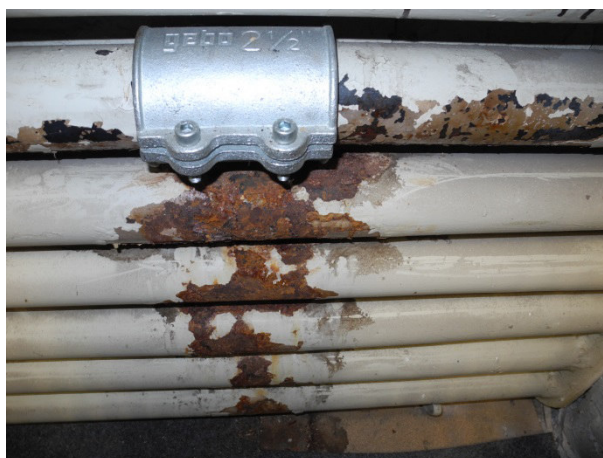
Repariertes Rohr eines Rohrheizkörpers
