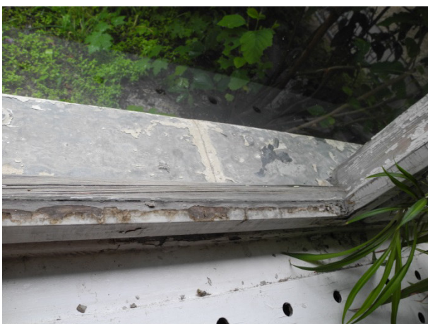
Beispiel Zustand der Fenster
