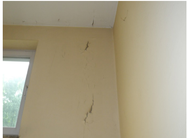
Abblätterungen an der Innenseite der Außenwand
