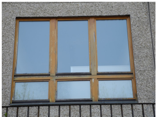
Beispiel Zustand erneuerte Fenster Süd-Westseite
