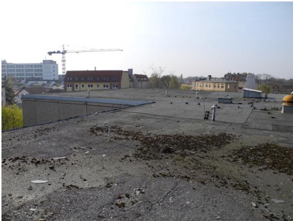
Dach des 2. Obergeschosses
