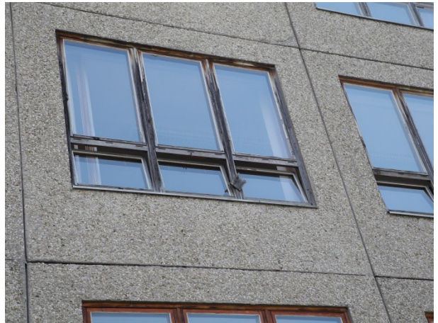
Beispiel Zustand alte Fenster Süd-Westseite
