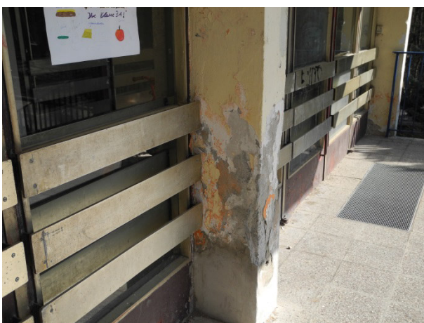
Zustand Stützen im Eingangsbereich
