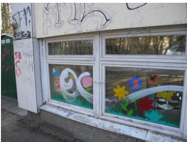
Beispiel Zustand der Kellerfenster auf der Nordseite
