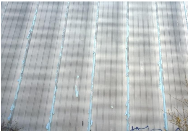
Zustand der Fassade auf der Nord-West-Seite
