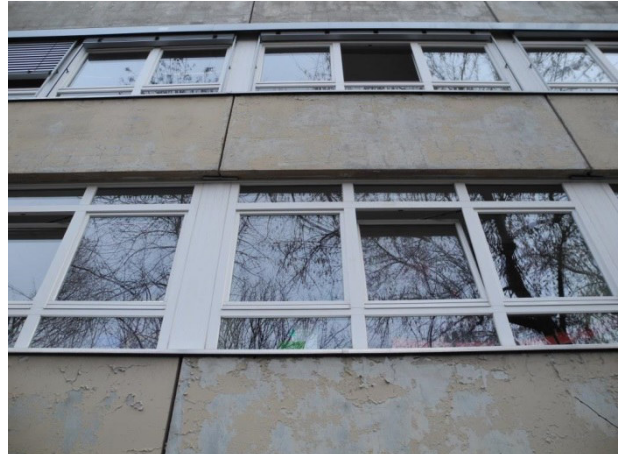
Zustand der Süd-West Fassade
