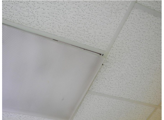
Defekte Deckenbeleuchtung
