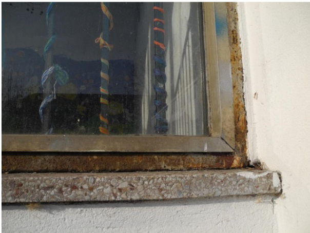
Zustand 1-fach verglastes Fenster
