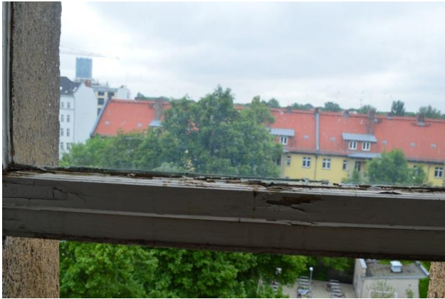
Beispiel des Zustands der Einfachverglasung in den TRH
