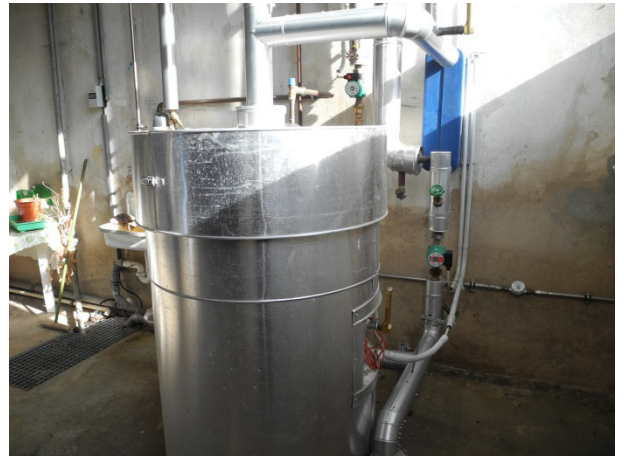
Warmwasserspeicher
