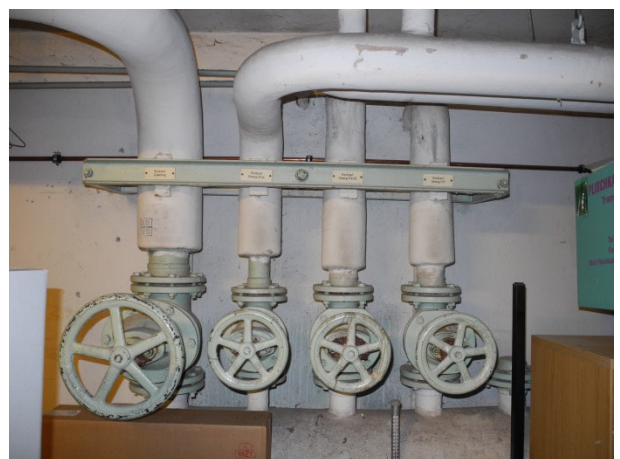
Rücklauf Verteilerstation
