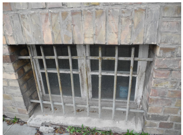
Beispiel altes Kellerfenster
