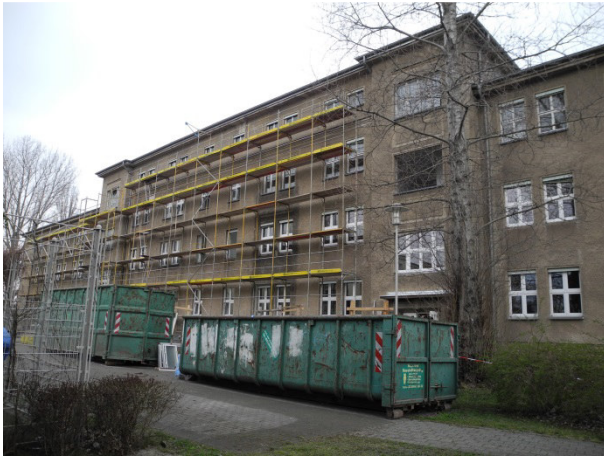
Süd-Ost-Ansicht mit Gerüst (Eingangsseite)
