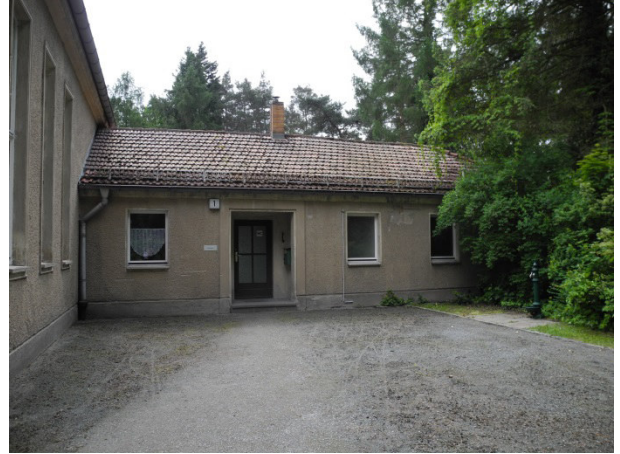
Nord-Ansicht des Friedhofgebäudes
