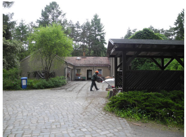
Süd-Ansicht des Friedhofgebäudes
