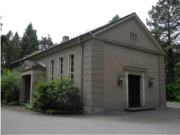
Nord-Ost-Ansicht der Feierhalle
