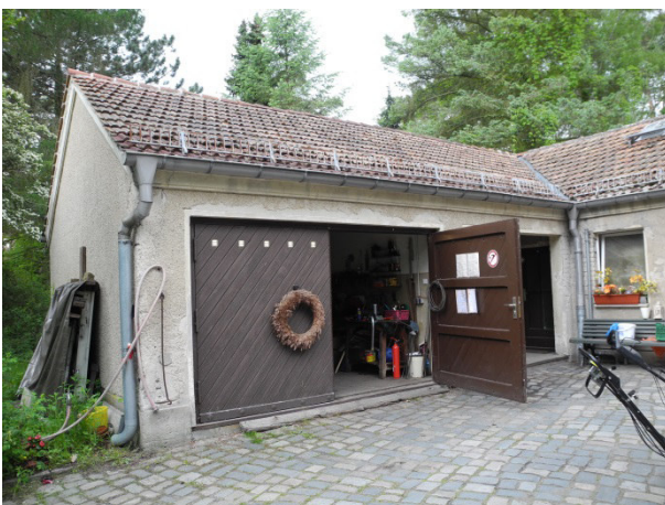
Ost-Ansicht der Lagerräume
