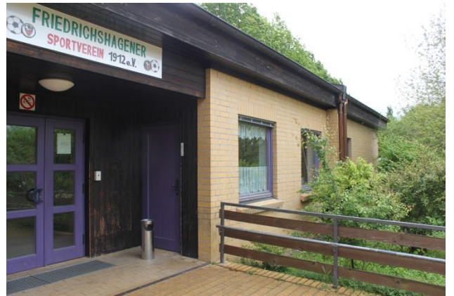
Intakte Klinkerwände und Holzschalung im Dachüberstand und Eingangsbereichen
