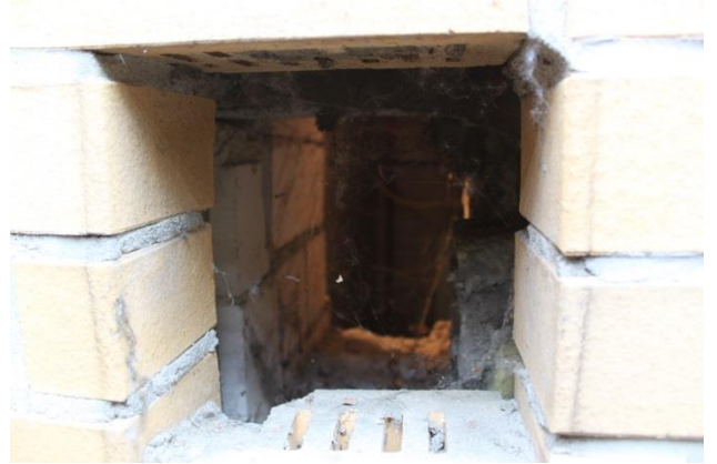
Zweischaliges Mauerwerk der Gebäudelängsseiten
