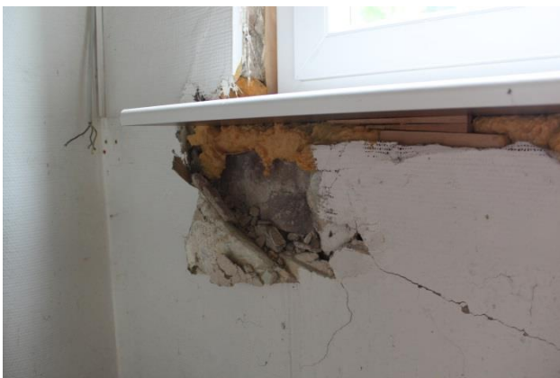
Innenputzschäden
