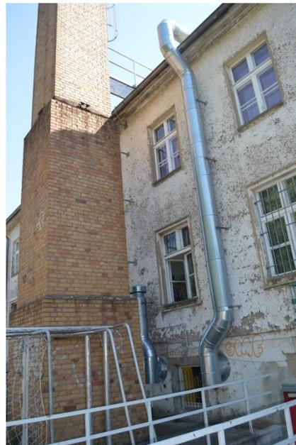
**Außenrohre der Lüftungsanlage im UG**
