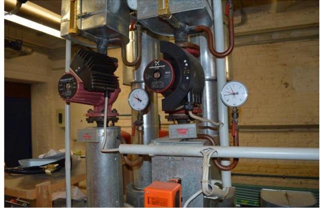
Heizungsumwälz- und Warmwasserbereitungspumpen
