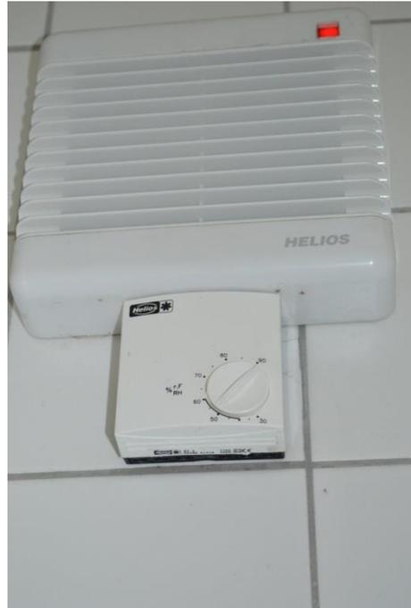
**Feuchtegeführter Abluftventilator im Sanitärtrakt im EG**
