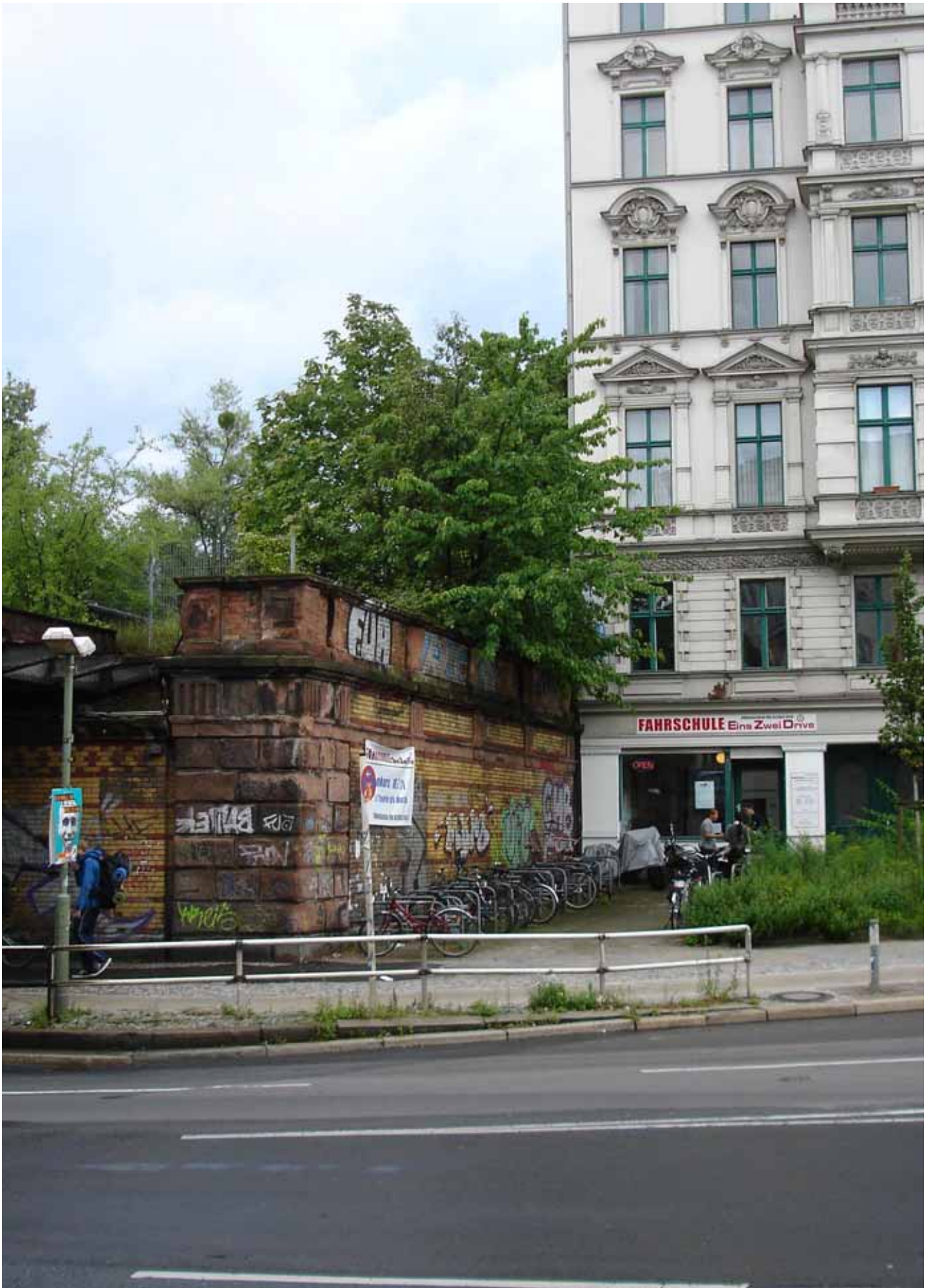
Flügelmauer am westlichen Vorplatz (Südseite) der Yorckstraße
