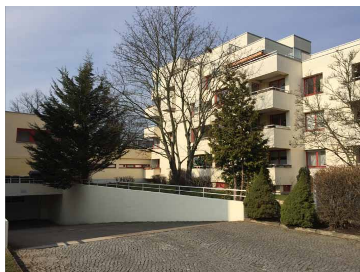
Abb. 11: Tiefgarageneinfahrt am Hoefweg; Quelle: büro13 Architekten
