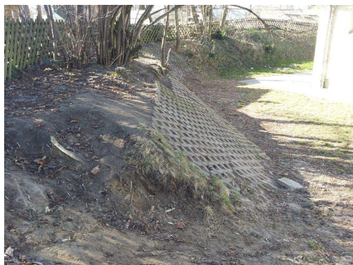
Sanierungsbedarf: erodierter Hang, verrottende Palisaden und abgebaute Einfassung Sandspielbereich
