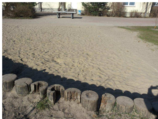
Sanierungsbedarf: erodierter Hang, verrottende Palisaden und abgebaute Einfassung Sandspielbereich
