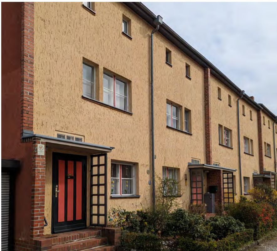
Historisch erhaltene Häuserzeile im Wohngebiet "Freie Scholle"
