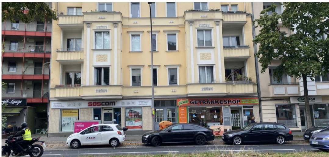
Abbildung 10: Geschäftsbesatz entlang der Scharnweberstraße im STZ Kurt-Schumacher-Platz
