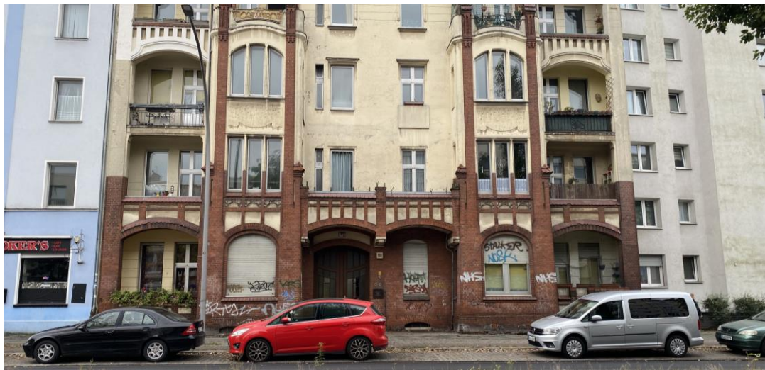
Abbildung 12: Leerstand in der Scharnweberstraße
