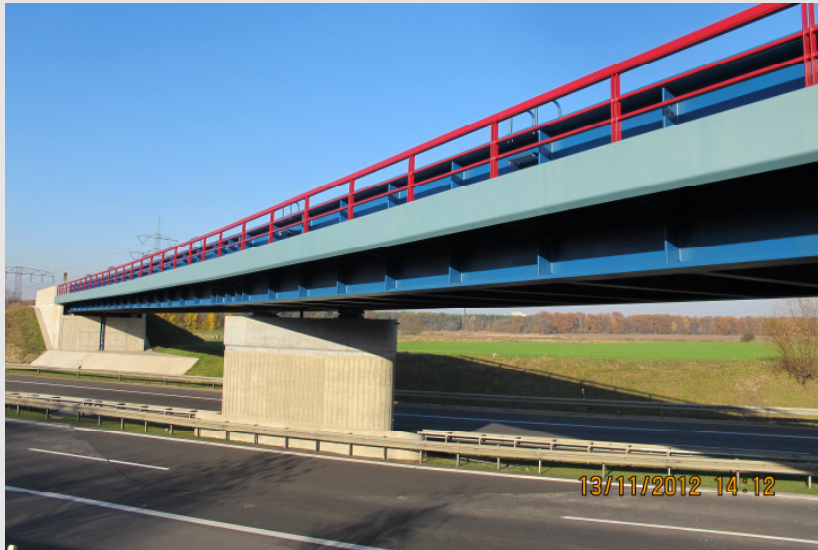
Bauwerk BW 88 Ü 2 Brücke der Regionalbahn NE 27
