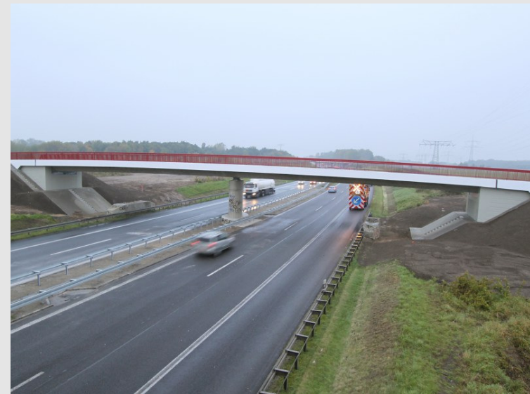
Bauwerk BW 88 Ü 3 Brücke im Zuge der Böhnkestraße
