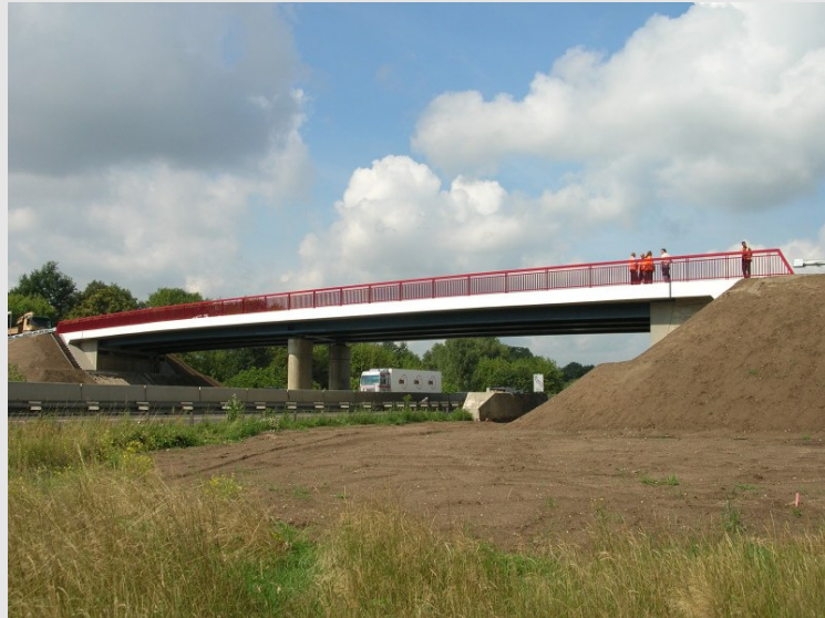
Bauwerk BW 88 Ü 1 Brücke im Zuge der Hobrechtsfelder Chaussee
