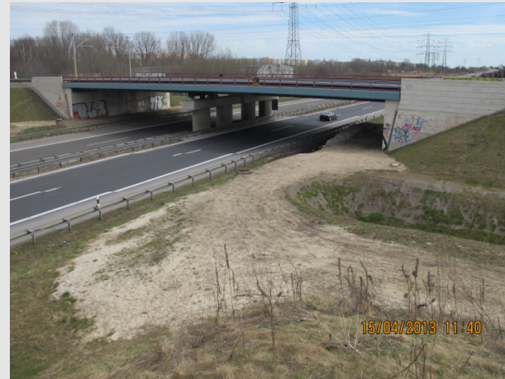
Bauwerk BW 88 Ü 4 Brücken der S- und Fernbahn DBAG
