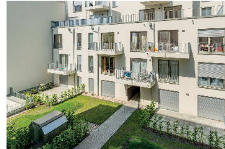
Abb. 120 Nutzbare Dachfläche des Supermarkts, Foto: Bransilav Jesic
