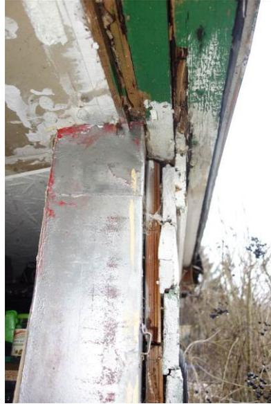
**Abbildung 31: Spalte an Laube über Türbereich (Parzellen-ID 2)**
