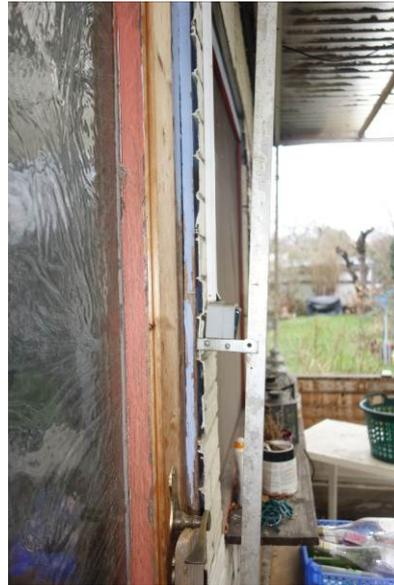
**Abbildung 38: Spalten hinter Verkleidung (Parzellen-ID 6)**
