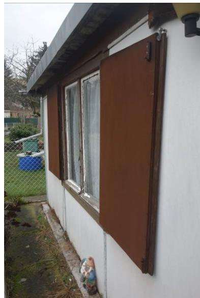
**Abbildung 73: Spalten hinter Fensterläden (Parzellen-ID 26)**
