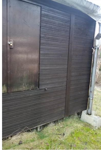
**Abbildung 66: Spalten hinter Holzverkleidung (Parzellen-ID 22)**
