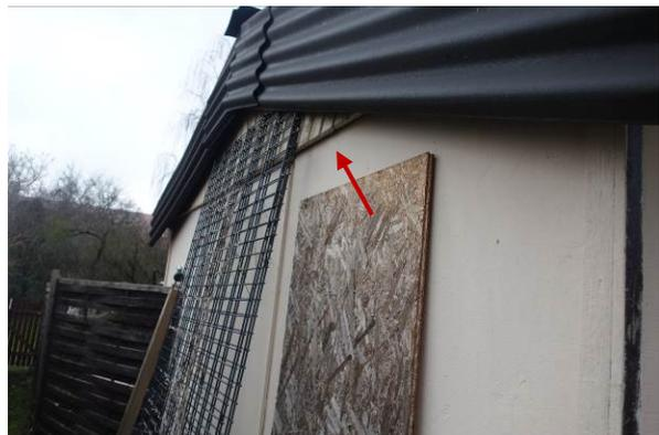
Abbildung 79: Spalten hinter Paneele (Parzellen-ID 30)
