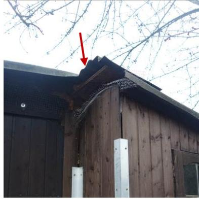
Abbildung 75: Spalte im Dachbereich (Parzellen-ID 27)
