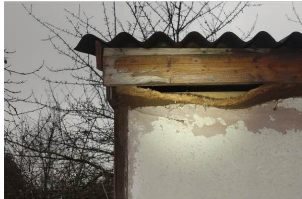
Abbildung 58: aufgerissener Dachkasten (Parzellen-ID 17)
