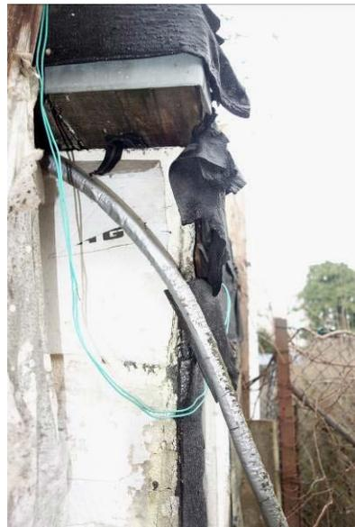
**Abbildung 40: Spalten hinter Dachpappe (Parzellen-ID 7)**
