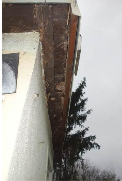
**Abbildung 34: Spalte am Dachüberstand (Parzellen-ID 4)**
