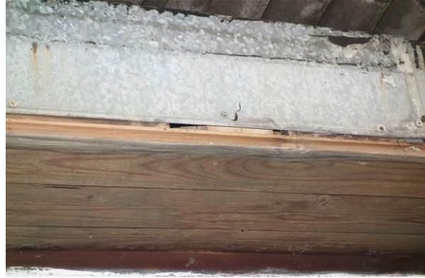
**Abbildung 42: Spalte über dem Dachkasten (Parzellen-ID 8)**
