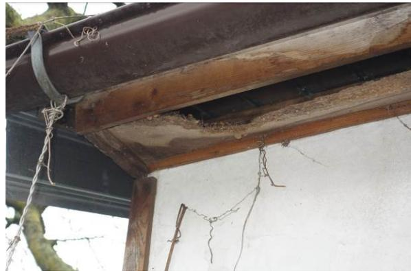
**Abbildung 44: aufgerissener Dachkasten (Parzellen-ID 9)**
