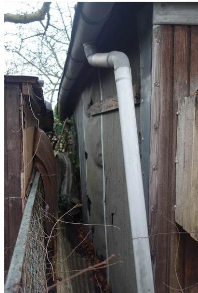
**Abbildung 48: Spalten hinter Dachpappe (Parzellen-ID 11)**
