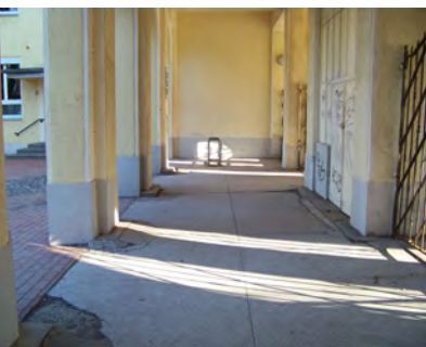
Eingangsbereich vor der Sanierung © HBA JOST
