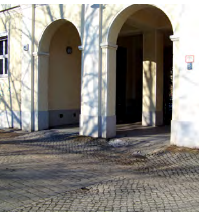
Eingangsbereich vor der Sanierung © HBA JOST
