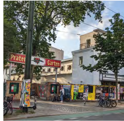
Prater, Kastanienallee nach der Sanierung © S.T.E.R.N. GmbH
