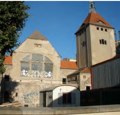
Stadtbad Oderberger Straße © S.T.E.R.N. GmbH
