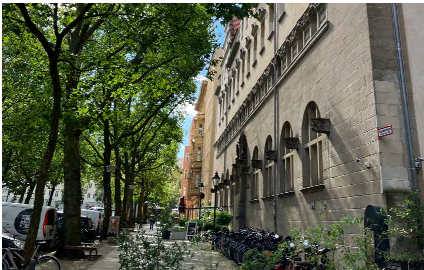
Stadtbad Oderberger Straße © S.T.E.R.N. GmbH
