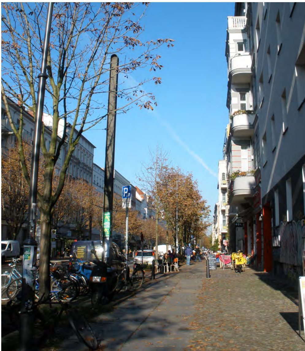
Gehweg Kastanienallee nach der Sanierung © S.T.E.R.N. GmbH
