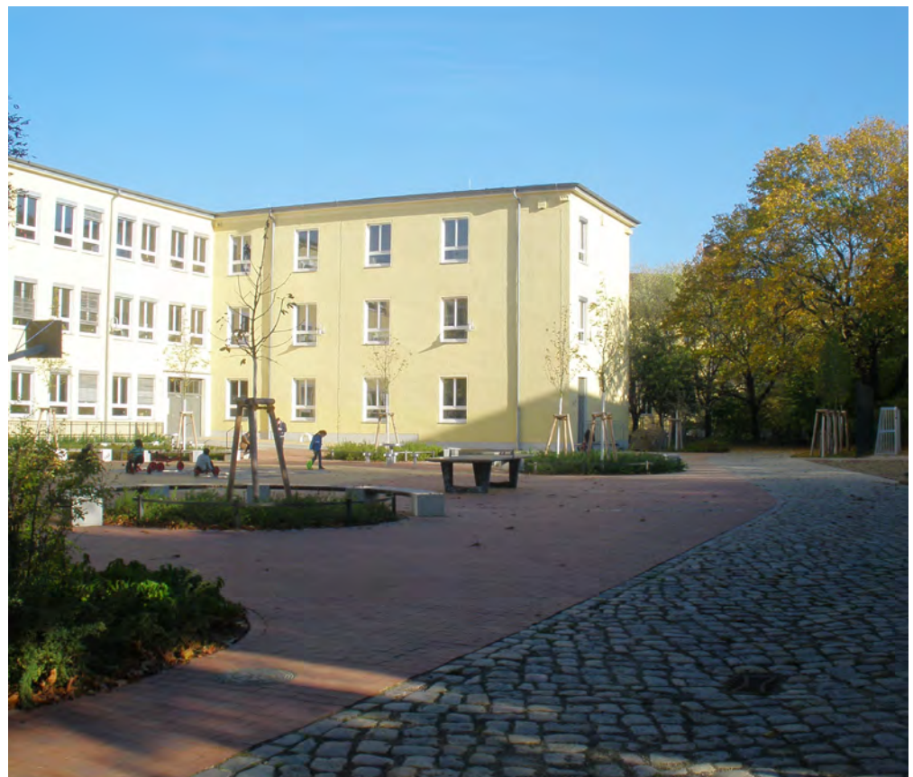
Grundschule am Senefelderplatz, Schönhauser Allee 165, 3. BA, Schulhof nach der Sanierung © S.T.E.R.N. GmbH
