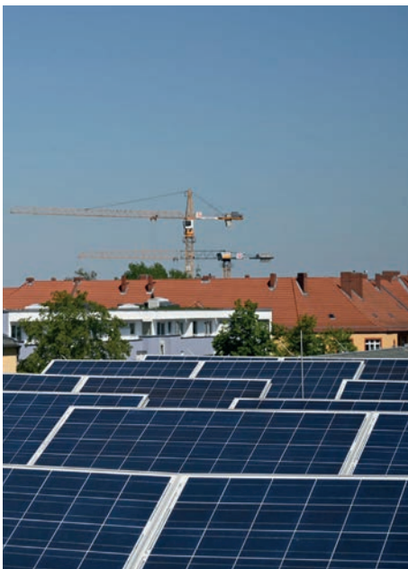
Solaranlage auf dem Dach der Klecks-Grundschule in der Brixener Str. 40
