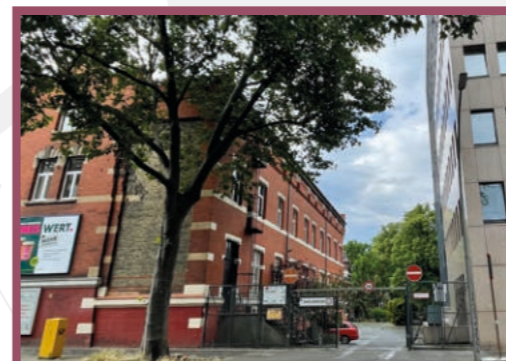
Lahnstraße 78, u.a. Bezirksamt Neukölln, mit Zufahrt zu privatem Grundstück. Blick geht in nördliche Richtung.
