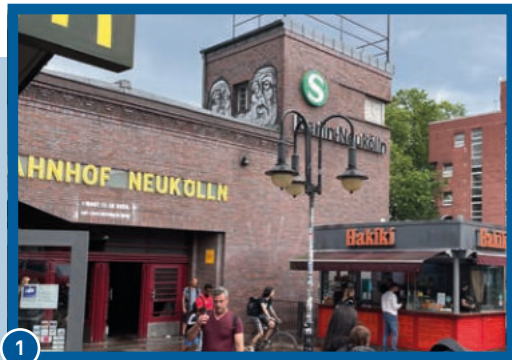
1 Denkmalgeschütztes S- und U-Bahnhofsgebäude Neukölln Karl-Marx-Straße Ecke Saalestraße in Blickrichtung Süd-West.
