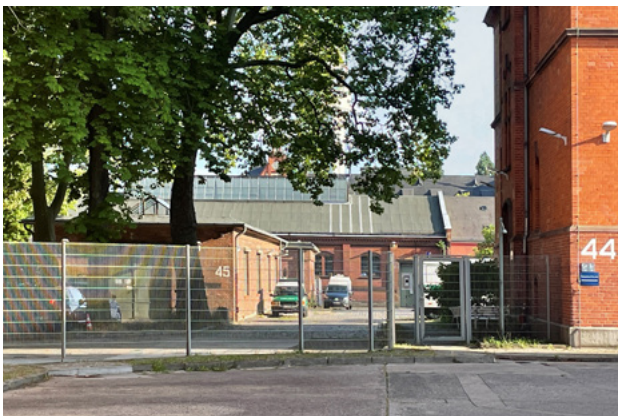
Abb. 3: Die Dachflächen der Hofgebäude in der Jüterboger Straße sind nur teilweise einsehbar
