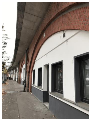
Abbildung 79: Renovierter Leerstand in den Stadtbahnbögen 396-397
