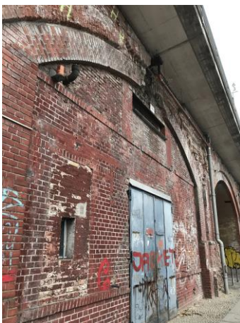
Abbildung 78: Mauerwerk des leerstehenden Stadtbahnbogens 366 in der Lüneburger Straße
