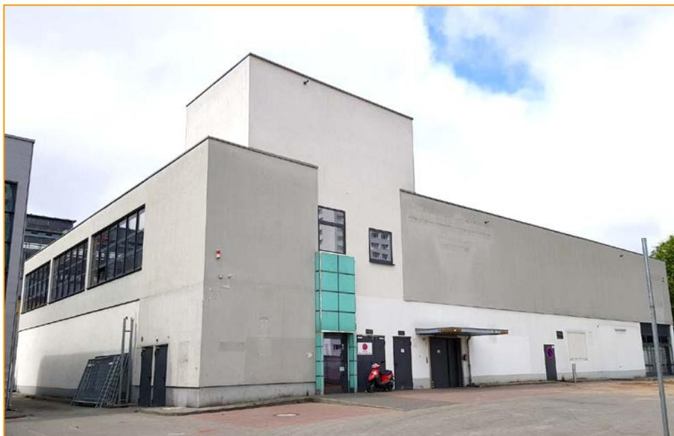
Abb. 5 Baufläche JAH02, Holzmarktstraße in Berlin-Mitte (Gebäude für Einzelhandel): Die Konstruktion der Dachkanten an den Abrissobjekten ist für eine Nutzung durch Gebäude bewohnende Fledermäuse oder Gebäudebrüter nicht geeignet.
